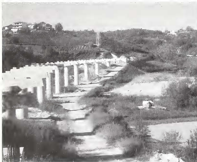
Fig. 3. Veduta panoramica del viadotto in costruzione su Rio Covasso.
